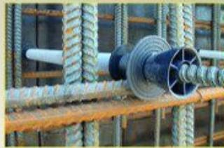
قطعه ای کارآمد برای آب بند نمودن انواع سازه های بتنی نظیر مخازن و استخرها که نیاز به آب بندی دارند. میان بلت پلاستیکی برای عبور بلت در قالب بندی استفاده می شود و دارای ۸ قطعه به شرح زیر می باشد
